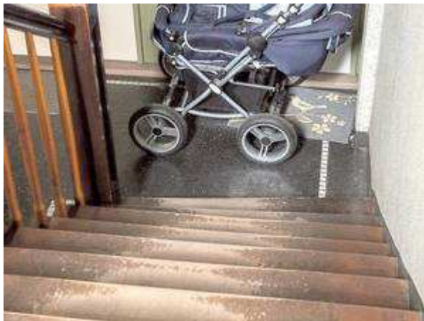
Ausnahme von der Regel? Ein Kinderwagen darf im Hausflur abgestellt werden. Allerdings muss genug Platz gelassen werden, damit die Fluchtwege frei bleiben. Foto: dpa - FOTO: DPA-TMN
